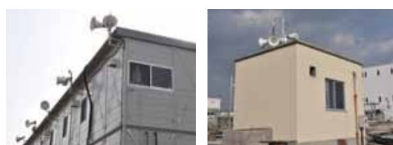
センター内を網羅するレフレックスホーンスピーカー+回転灯
