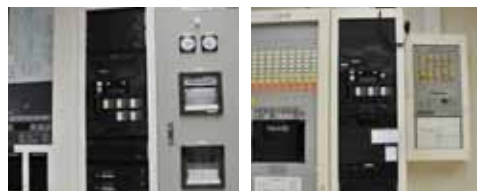
緊急地震速報を受け、管理棟の非常放送設備のデジタルミュージックマシン(音声メッセージ)が自動放送
