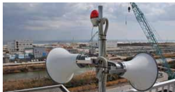
緊急地震速報を受け、管理棟の非常放送設備のデジタルミュージックマシン(音声メッセージ)が自動放送
