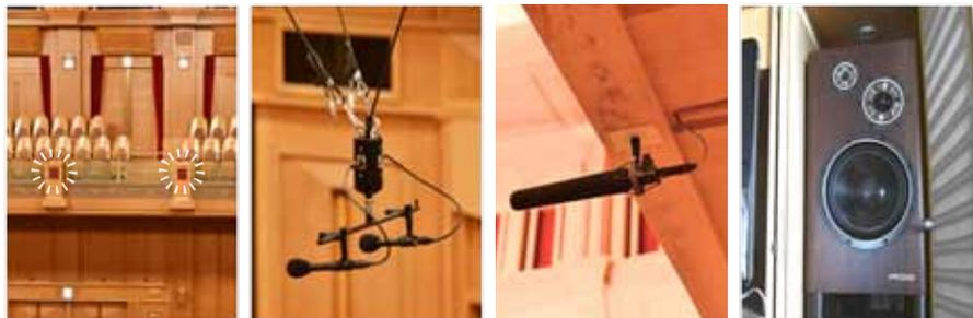
▲装飾に施されたスピーカー ▲サラウンド対応3点吊りマイク ▲固定マイク ▲バーコーナー用スピーカー
