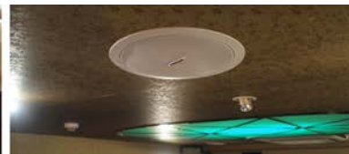
B1Fバー「ジャルダンデルテ」は 天井埋込型のスピーカーシステム
