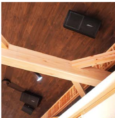
明瞭度が高く自然で柔らかい音響は木造と藁束入り土壁によるものと思われる
