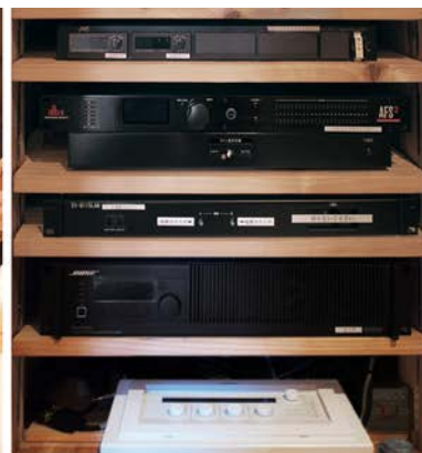
操作機器は本堂前室に集約他の部屋とも音響コンセントでつながる
