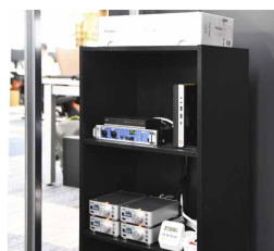
シンプルな送出系機器ラック
