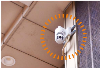
水平360°/垂直-30°+30倍ズームのPTZカメラ
