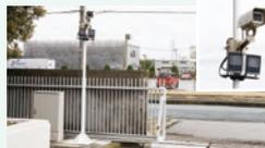
逆光にも強いハウジング取容の高解像度カメラ。夜間用LED投光器も装備。
