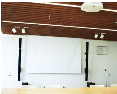
ラインアレイスピーカー、ウーハー、埋込スピーカーの配置で音量のバラつきなく重低音の効いた音響を実現
