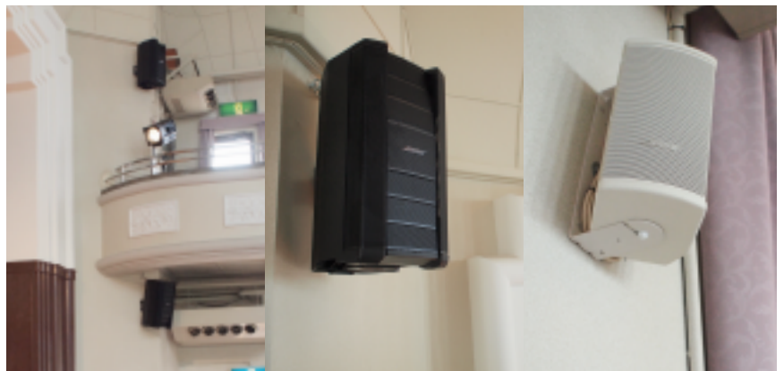
広い講堂の隅々まで音を届けるため、サイズは小型ながらパワフルなBOSE社製スピーカーから最適モデルを、その特長を生かして適所に配置、観客席内ではほぼ均一な音圧分布を実現
