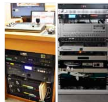
▲PM-5000シリーズのユニット機器などは操作性を考慮し、ラック2台に収納
