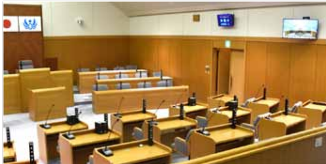
▲議場内の全マイク・自動追尾HDカメラ・文字テロップが連動し、議事進行をサポート
