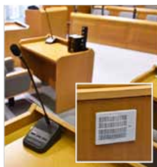
▲議席マイクはモニタースピーカー内蔵、傍聴席にはシーリングスピーカー
